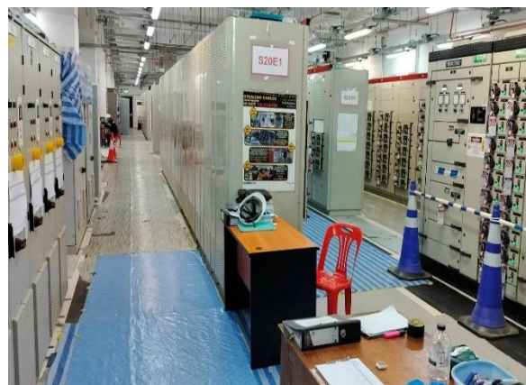
รูปที่ 1-2 งานติดตั้งอุปกรณ์ภายในห้อง Substation
