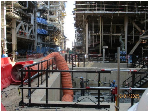
รูปที่ 1-4 งานก่อสร้างภายในพื้นที่อับอากาศ
