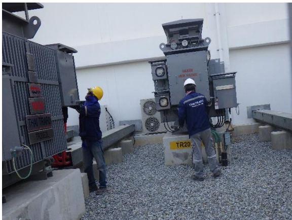
รูปที่ 1-6 งานการติดตั้ง/บำรุงรักษาหม้อแปลงไฟฟ้าแรงสูง
