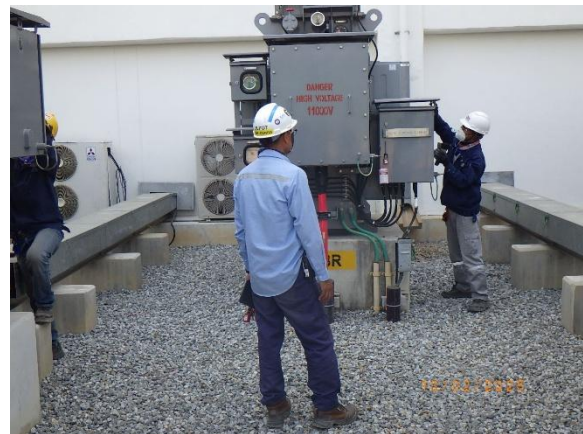
รูปที่ 1-6 งานการติดตั้ง/บำรุงรักษาหม้อแปลงไฟฟ้าแรงสูง
